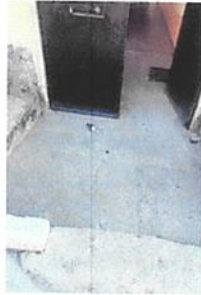
Foto 1 TORTA DE CONCRETO
