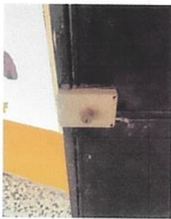
Foto3 Cambio de chapas
