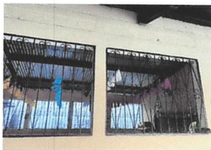
foto 5 cambio de ventanas
