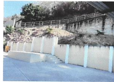
foto 4 pintura en muros
